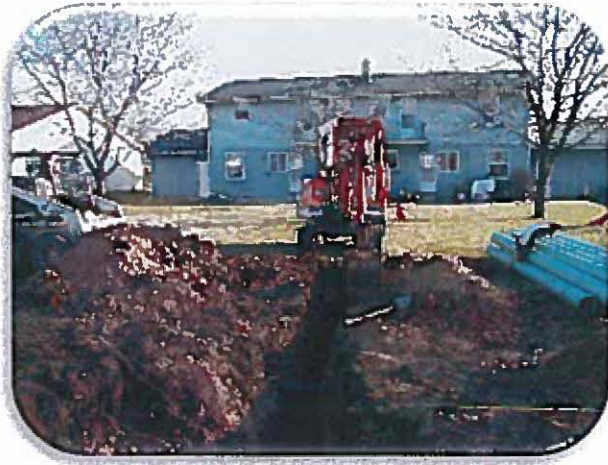
Mini Storm Sewer Installation - Backyard
