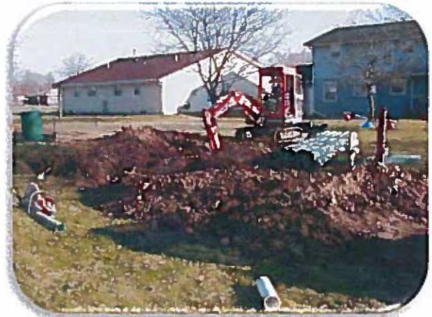
Mini Storm Sewer Installation - Backyard
